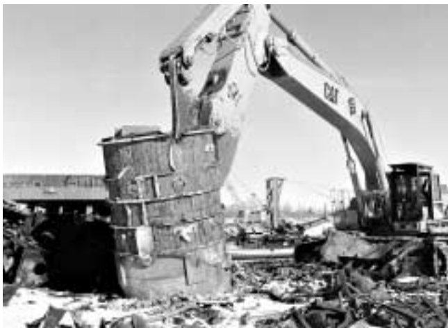
Заключительный этап утилизации АПЛ на заводе «Звездочка» в Северодвинске – разрушение ракетной шахты
