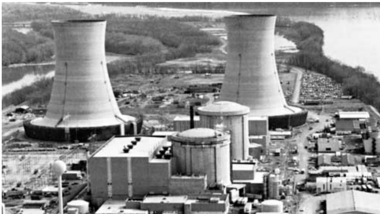
28 марта 1979 года возникшие на АЭС Три Майл Айленд в Пенсильвании (США) неполадки оборудования и ошибочные действия персонала привели к частичному расплавлению активной зоны реактора
